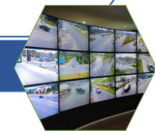
ศูนย์ควบคุม CCTV
